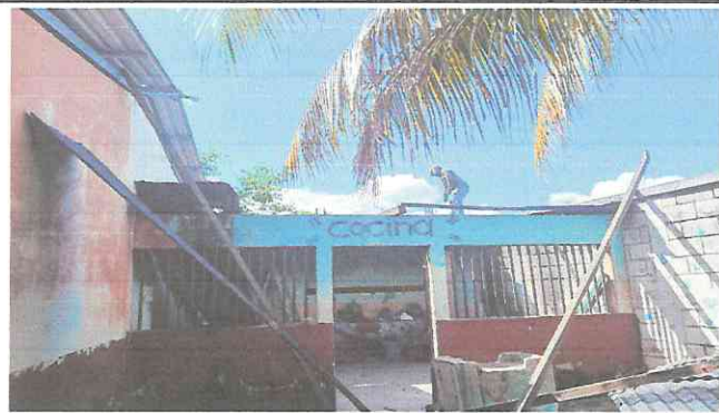
Foto 3. cambio de estructura y lamina de cocina.
