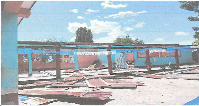
Foto 1: Cambio de estructura y lámina de dos aulas
