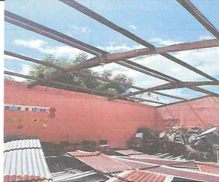
Foto 2: Cambio de estructura y lámina de dos aulas
